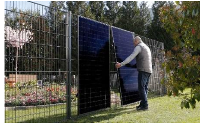
Figura 14: Paneles solares implementación vertical.
