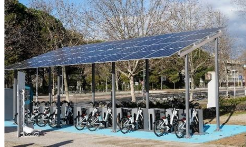
Figura 16: Paneles solares techo
