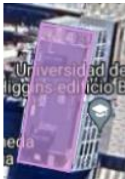
Figura 17: Implementación turbinas eólicas techo edificio B. Fuente Obtenida de Google Earth.
