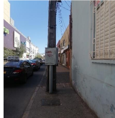
Imagen 2. Poste de luz obstaculizando tránsito peatonal en calle Mujica
