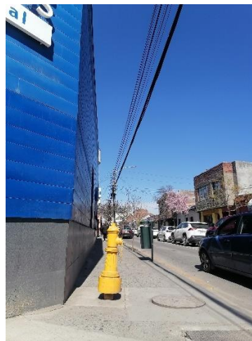
Imagen 3. Grifo de agua obstaculizando tránsito peatonal en calle Bueras
