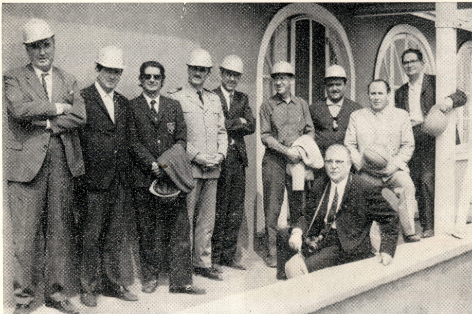
Altos funcionarios: Los miembros de la H. Junta General de Aduanas y el superintendente de los Servicios, señor Alberto Libano, en el "porche" de la Casa 18 en Sewell.
